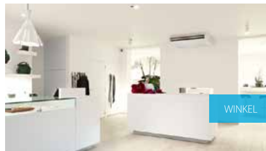
Plafondonderbouwmodel FXHQ-A: lage inbouwhoogte voor brede ruimtes zonder verlaagd plafond of vrije vloerruimte
